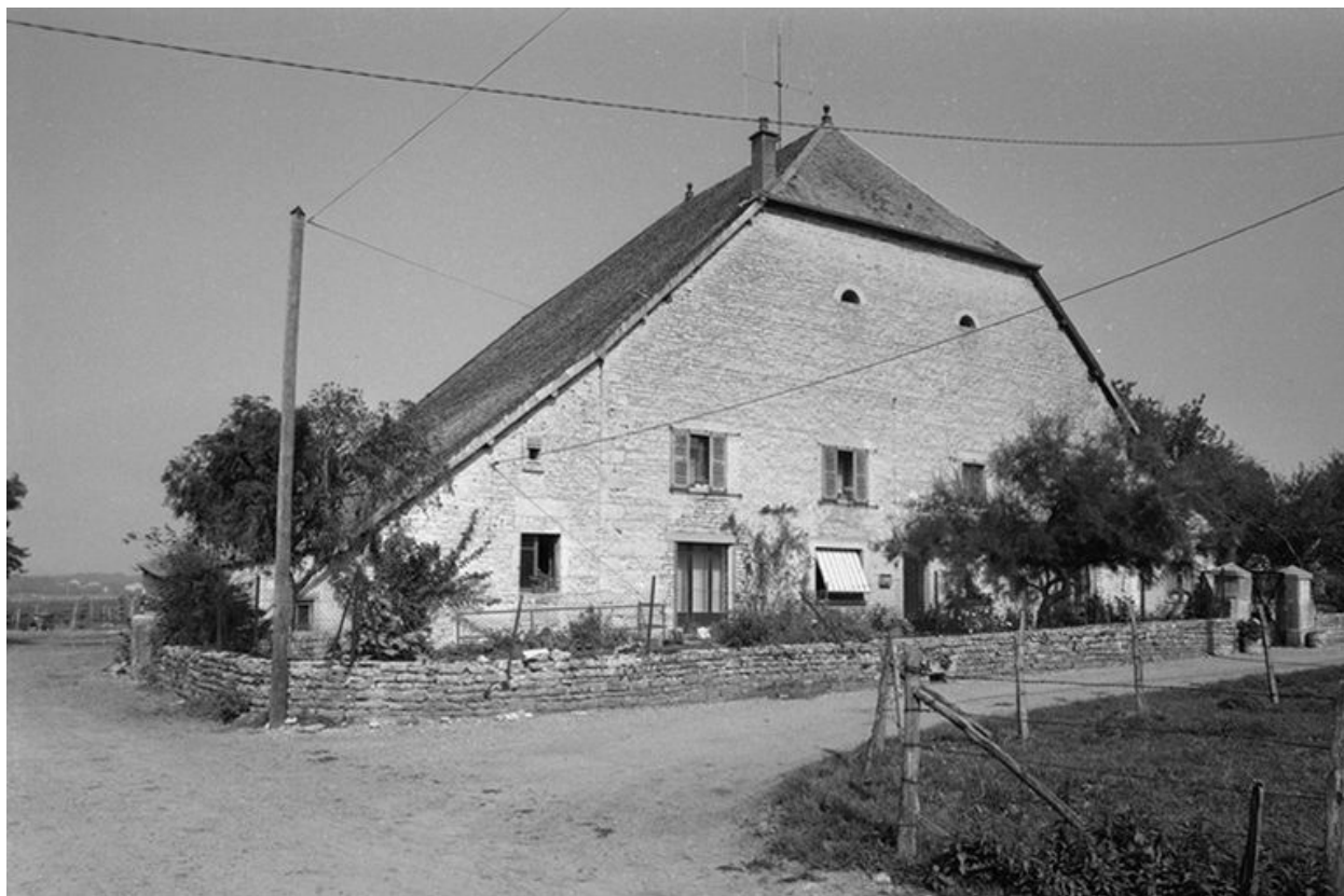
Ferme située rue du Camp.
