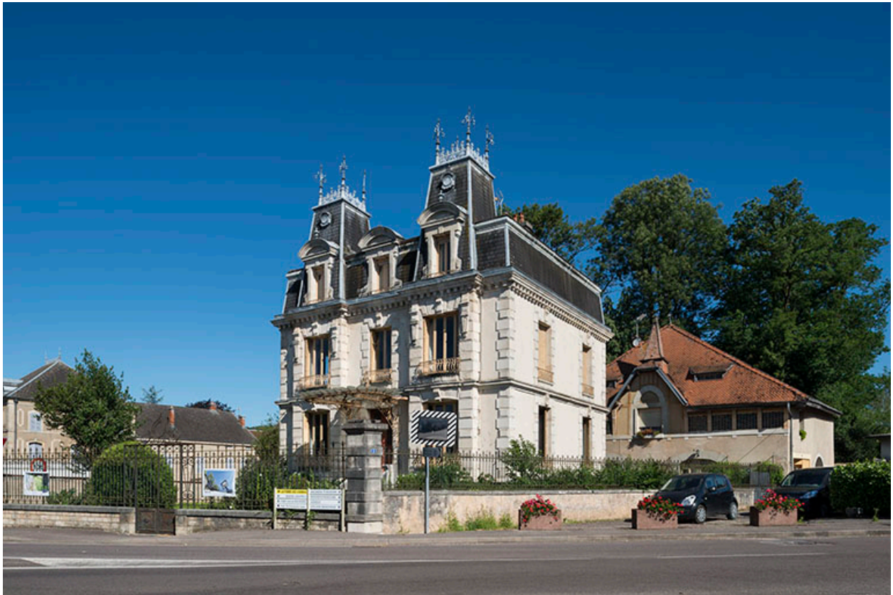
Vue d'ensemble de la maison et du bâtiment secondaire.
