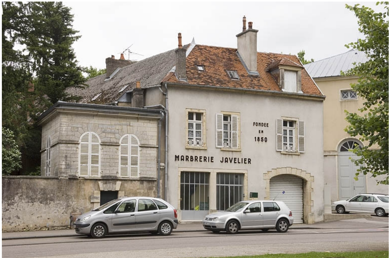
Vue d'ensemble depuis la rue Revon.
