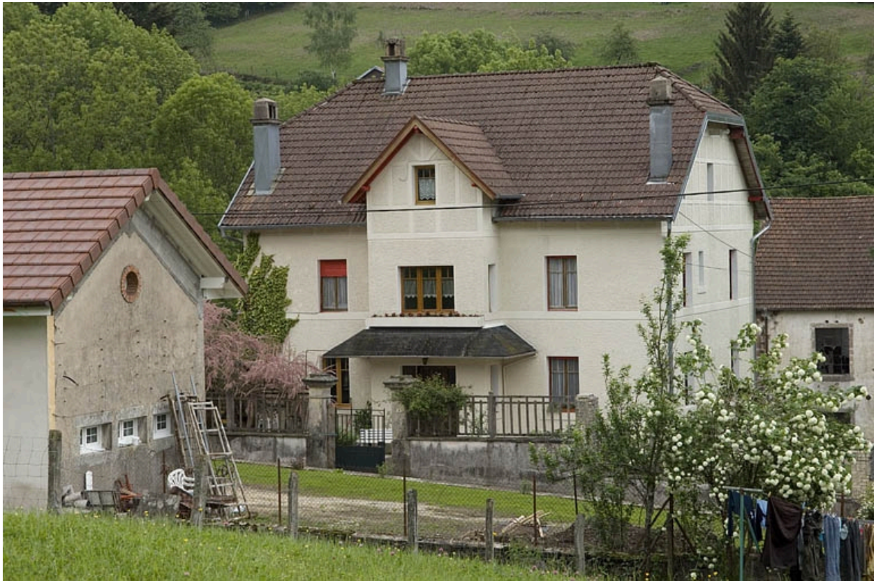
Logement du comptable (rue de la l'Usine aux Cités).
