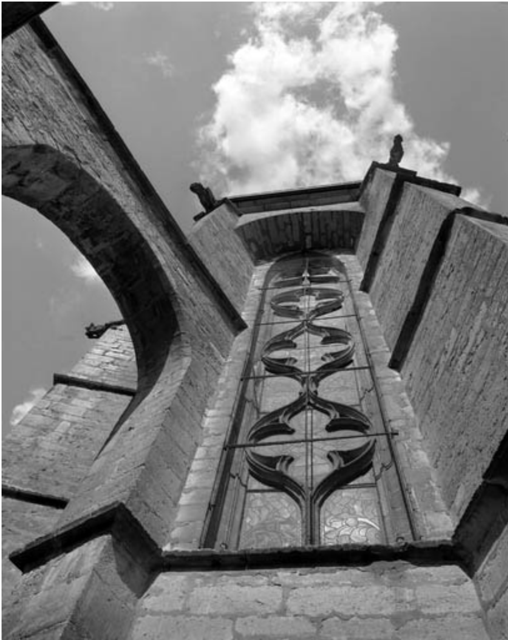
Chevet : détail d'une baie.
