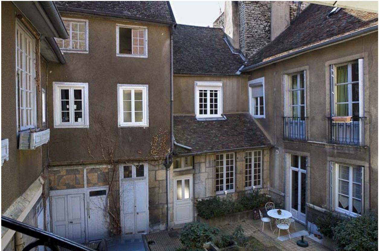
Vue des bâtiments autour de la cour, de trois quarts gauche.
