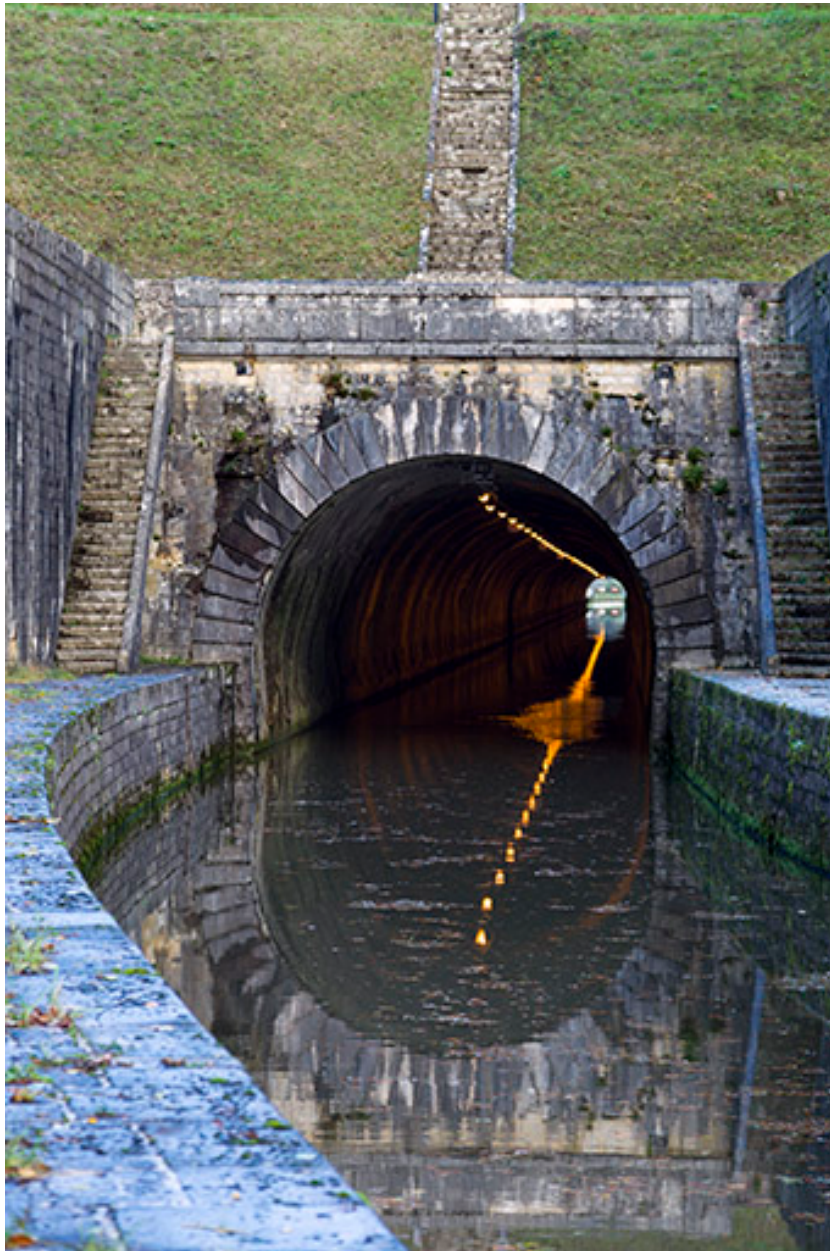
Le tunnel depuis l'aval.
