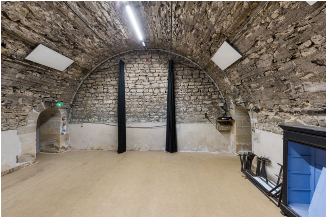
Etage de soubassement, partie centrale : 2e cave, vue de la grande cave.
