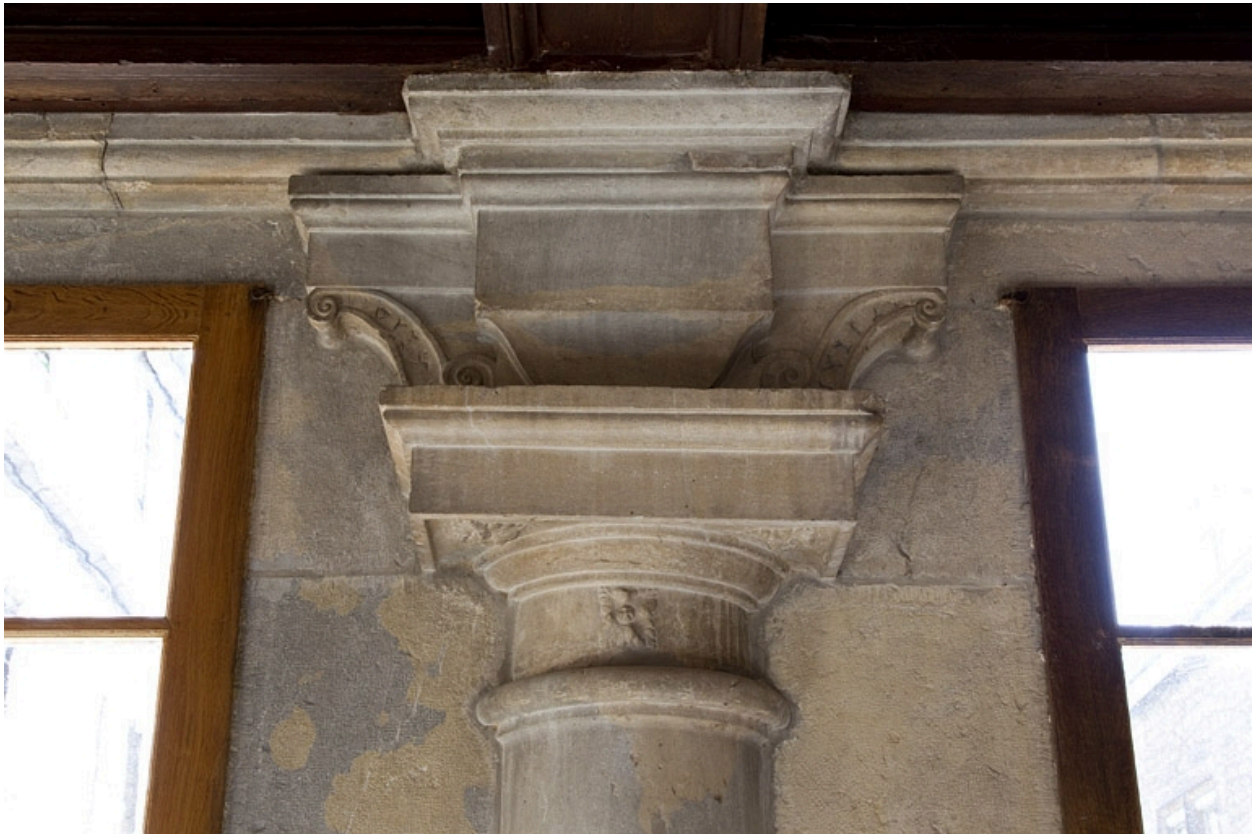
Logis principal, intérieur du portique : détail d'une zapata de face.
