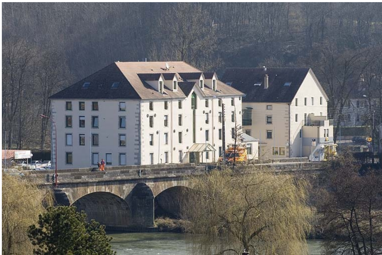
Vue d'ensemble depuis l'ouest.
