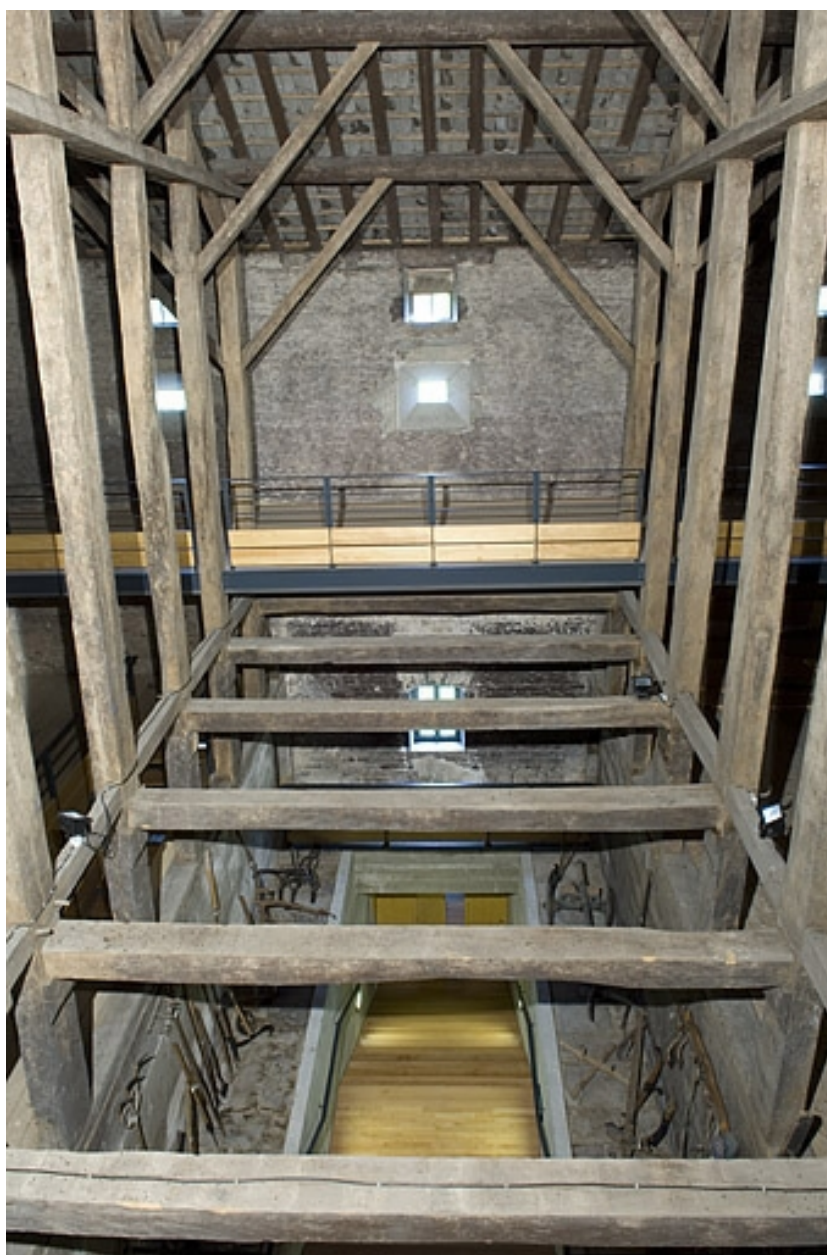
Charpente du fenil. travée centrale.
