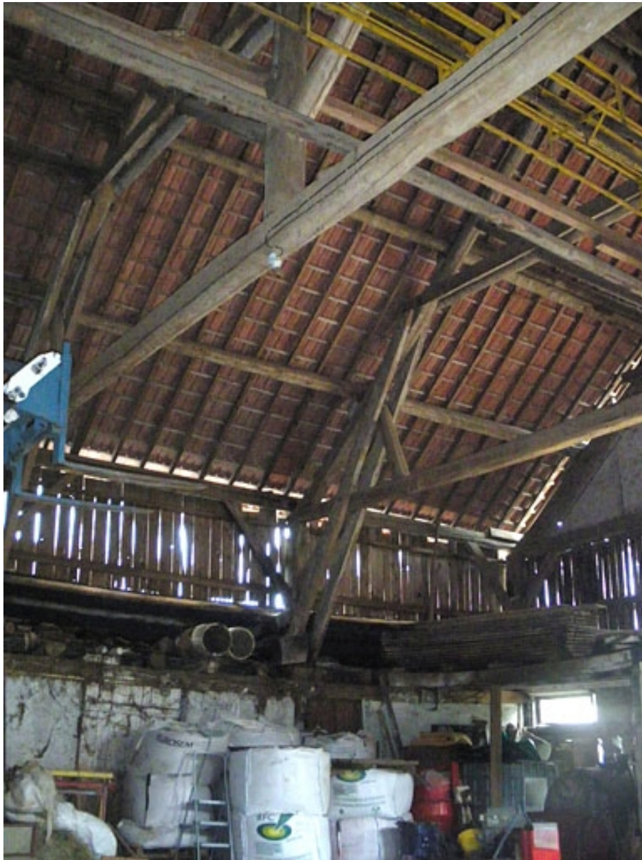
Remise agricole : charpente.
