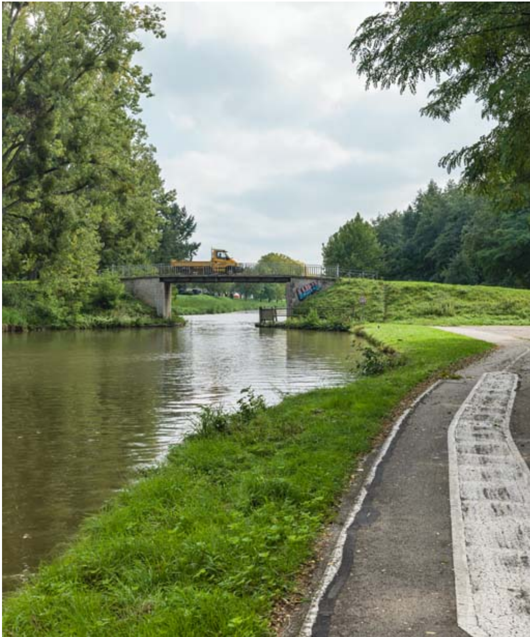
Vue d'ensemble du pont.
