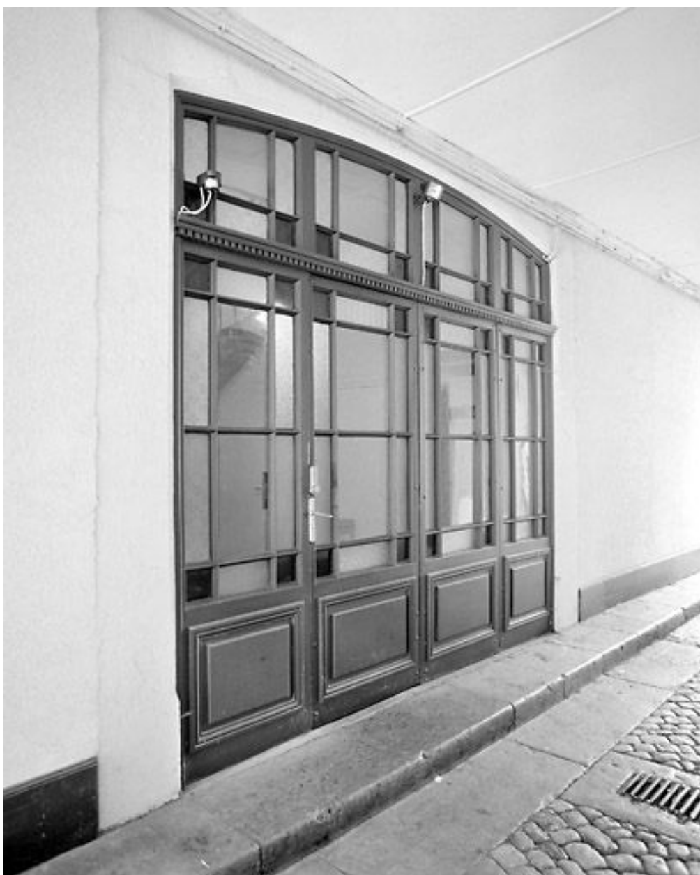
Passage couvert : porte de l'escalier.
