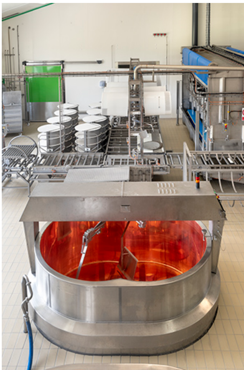
Vue plongeante sur une cuve.
