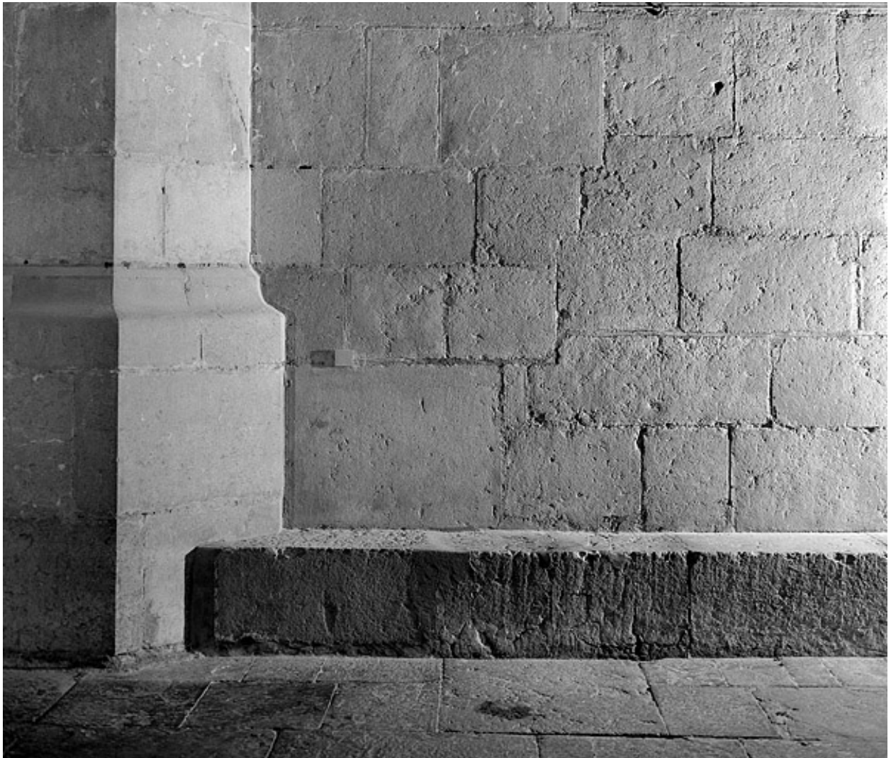
Détail du parement du revers de la façade au nord.
