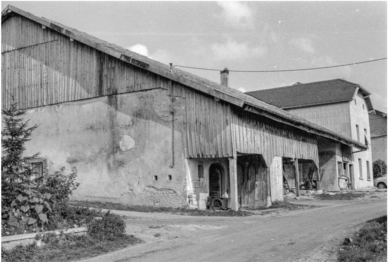
Ferme cadastrée 1945 D 128-129 : façade sur rue.
