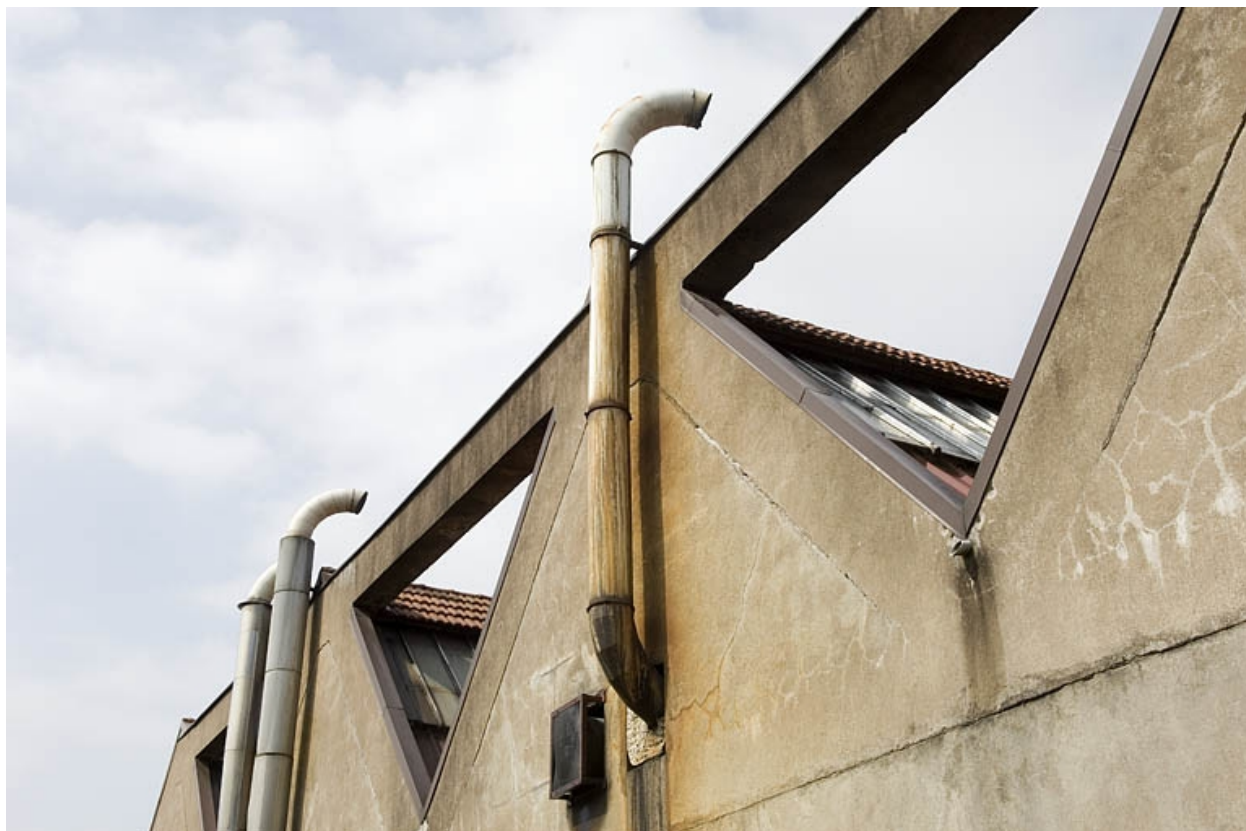
Pignons de l'atelier de fabrication. Détail.
