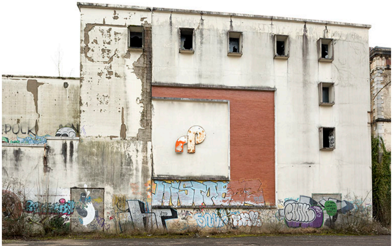
Etat en 2016. Usine A : extrémité occidentale de l'atelier d'étirage tergal (S).
