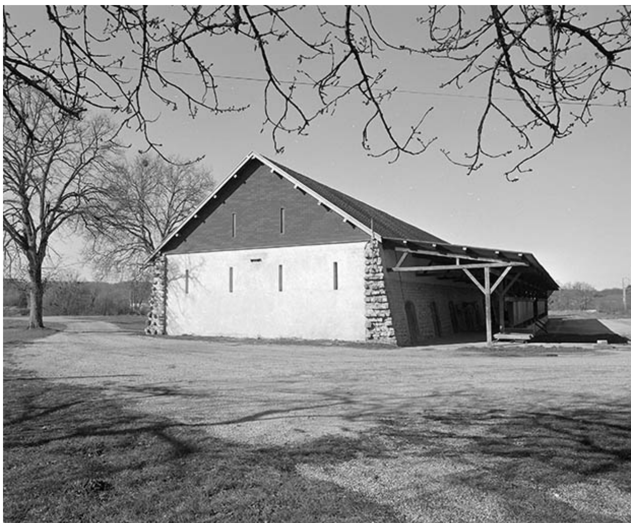
Extrémité orientale du magasin industriel.
