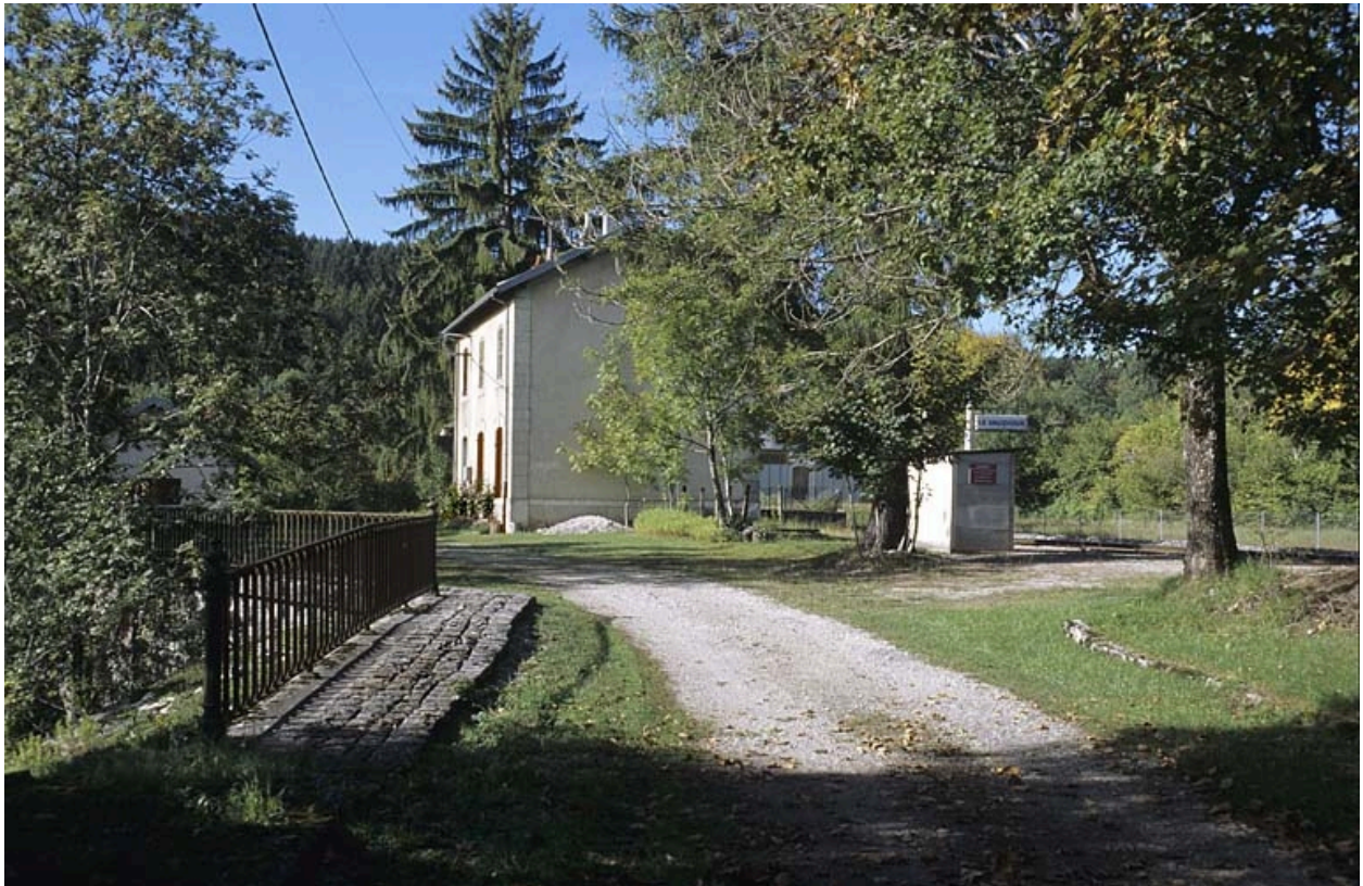
Bâtiment des voyageurs depuis le chemin d'accès, au nord-est.
