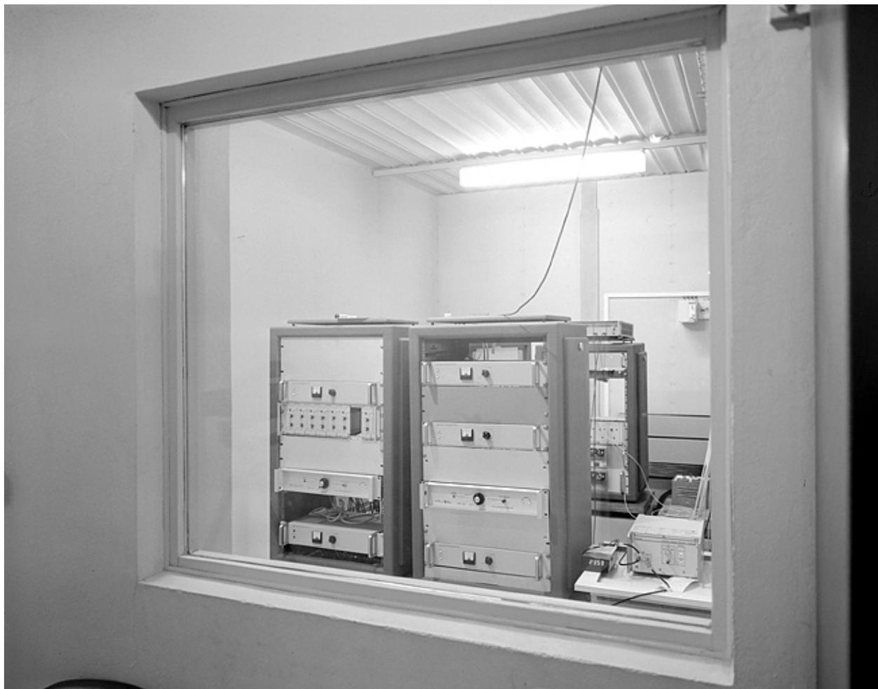
Salle des amplificateurs de distribution et des horloges à contrôler. Cette salle accueille les horloges à contrôler déposées par des clients extérieurs et les amplificateurs de distribution, qui dupliquent sans le dégrader en N exemplaires (N = 8 généralement) le signal provenant d'une horloge atomique.
