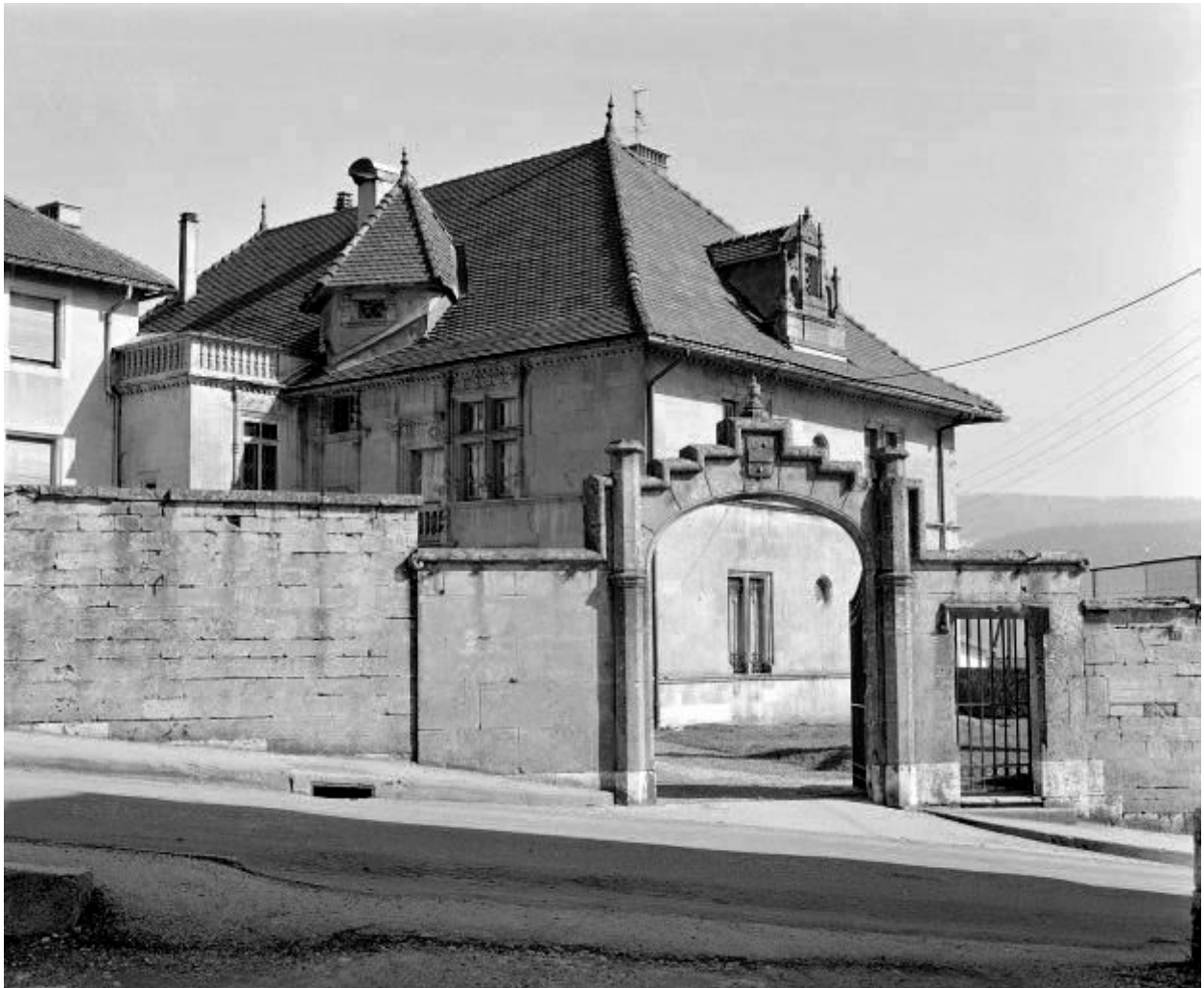
Portail d'entrée et façade sur cour.
