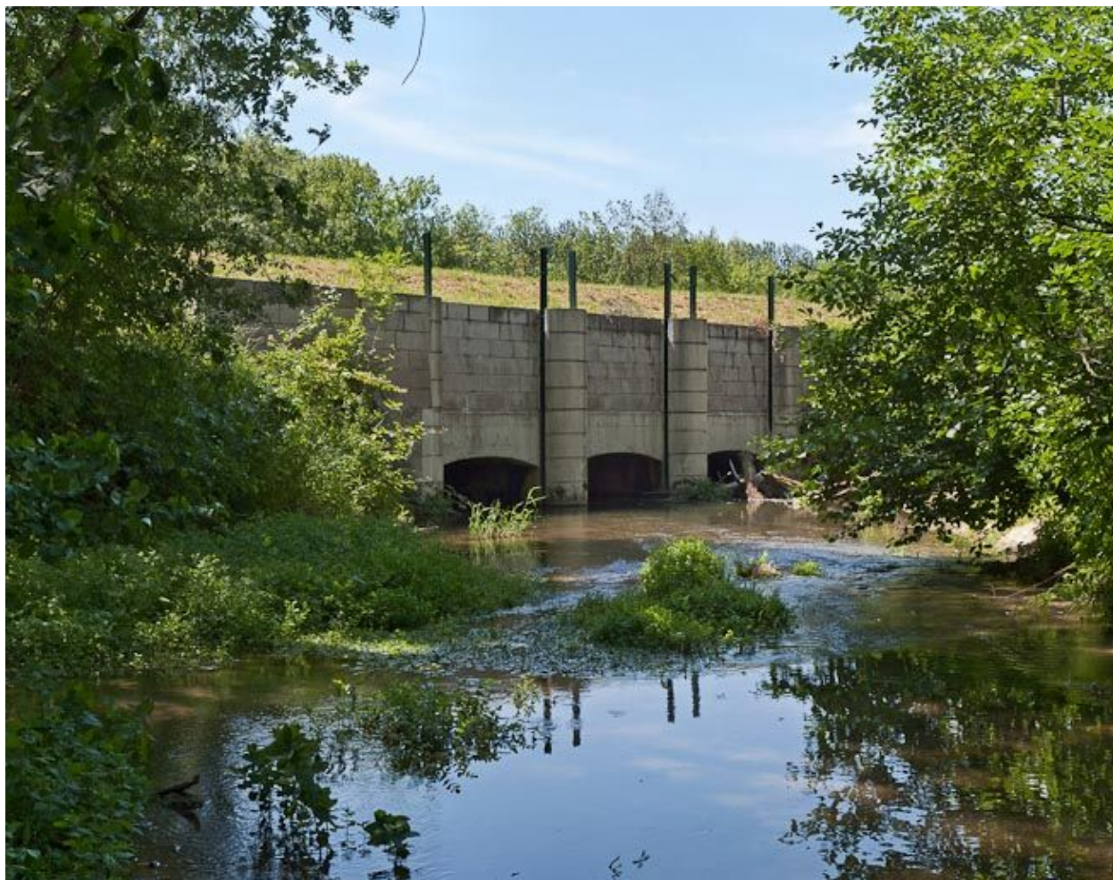
Vue de l'aqueduc.
