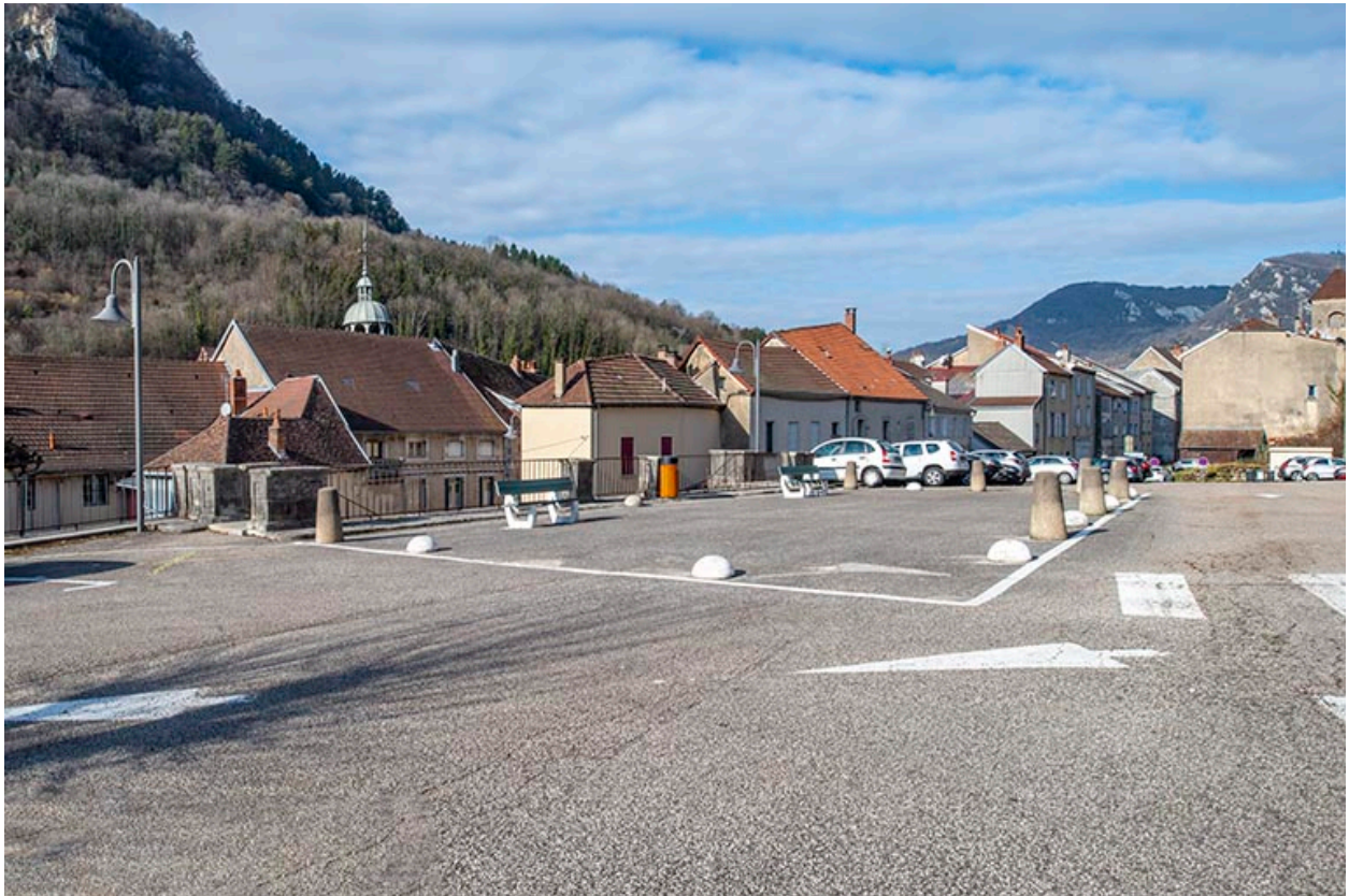
Couverture du réservoir, vue de la place Saint-Jean.
