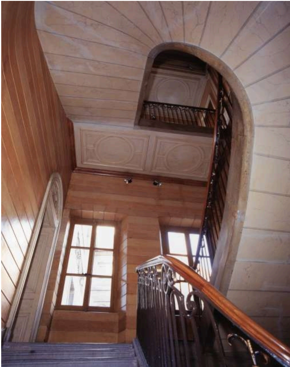
Vue d'ensemble de la cage de l'escalier d'honneur depuis le premier repos.
