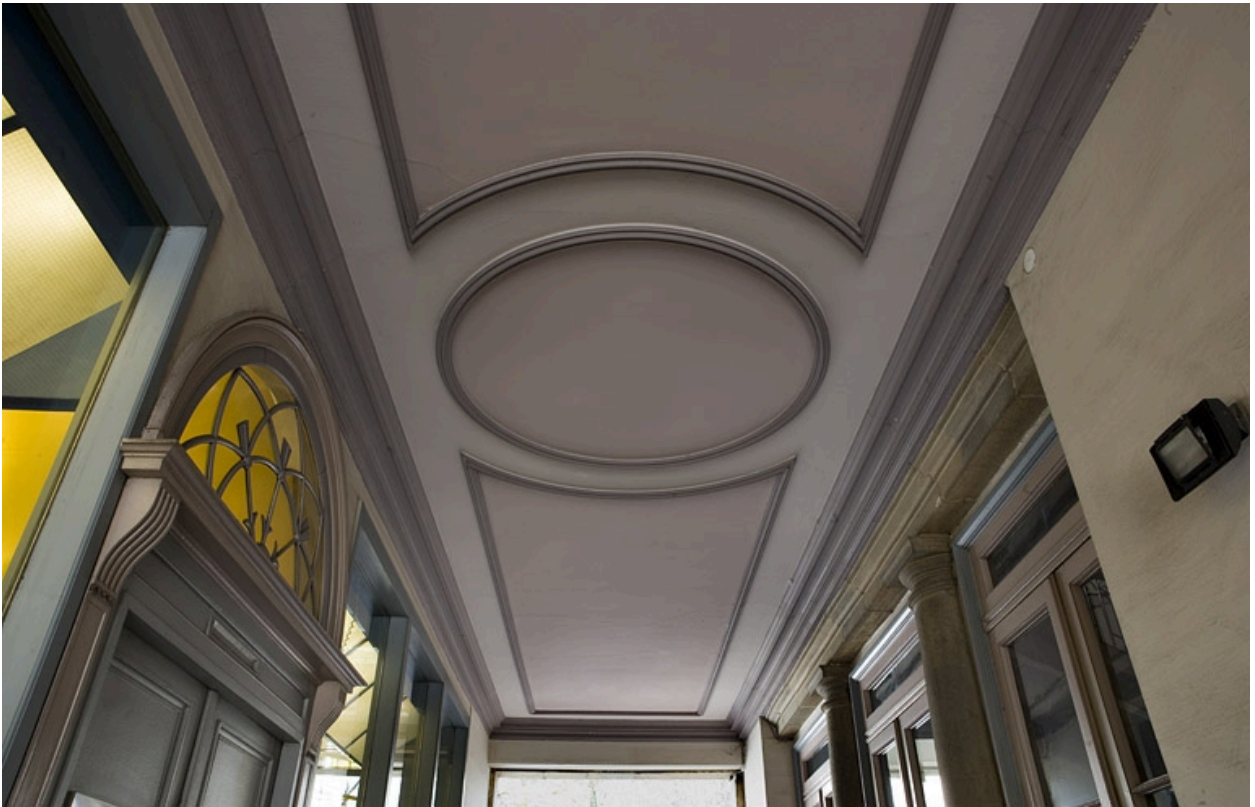
Vue d'ensemble du plafond passage cocher depuis l'entrée.
