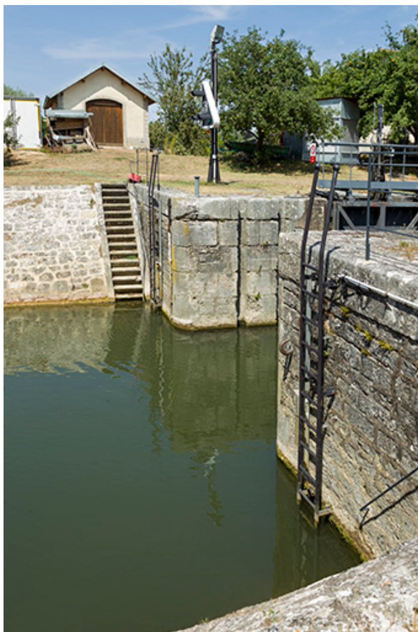
Vue sur la tête de l'écluse.
