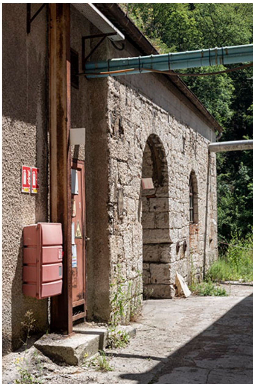
Bâtiment d'eau : façade antérieure, vue en enfilade.
