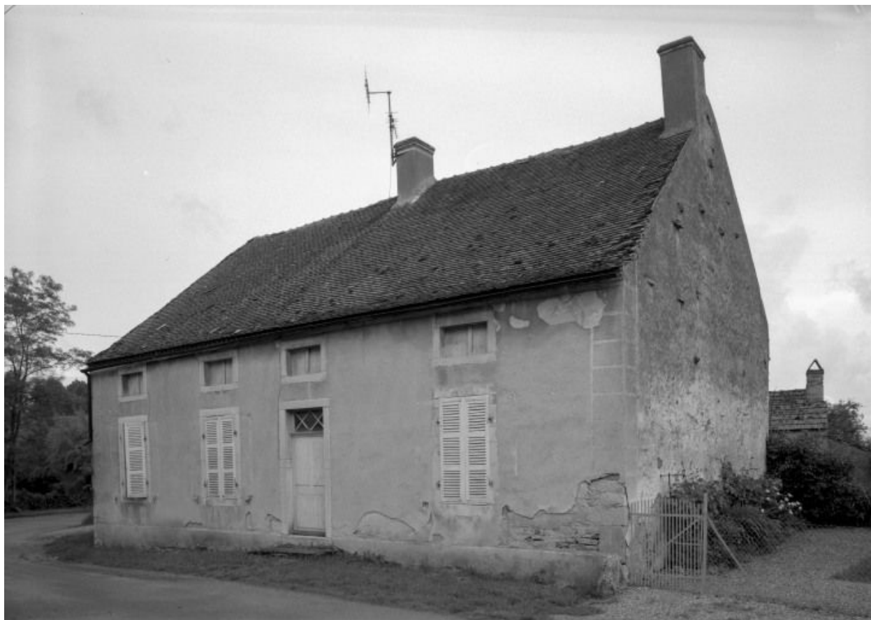
Vue d'ensemble du logis d'une ferme (cad. 1937, sect. A2, parc. 444).
