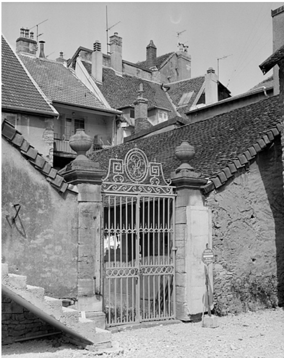
Maison, 5 rue Saint-Désiré, portail d'accès au jardin.
