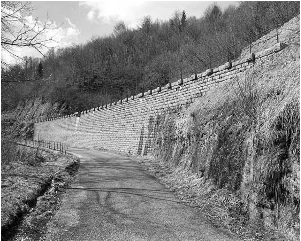
Mur de soutènement de la voie : vue d'ensemble, de trois quarts droite (est).
