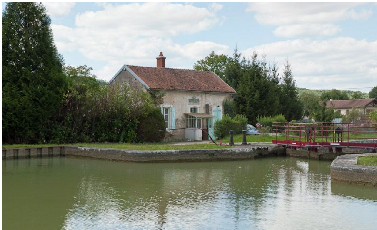
Vue du site d'écluse depuis l'amont.
