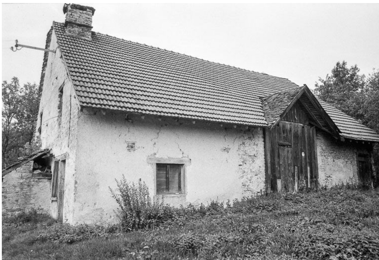
Façade latérale droite.
