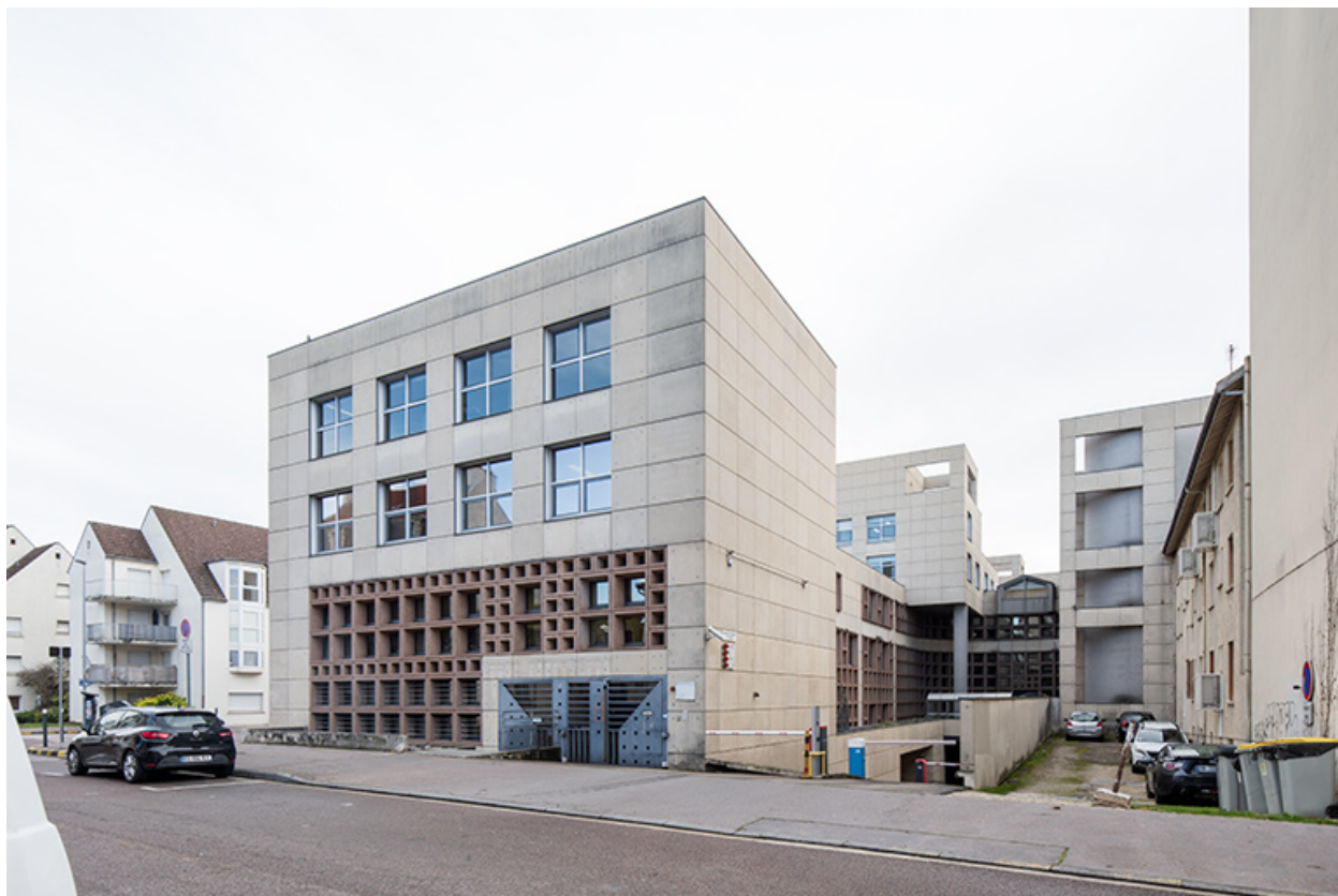
Façade sur la rue Parmentier, et rampe d'accès au sous-sol.
