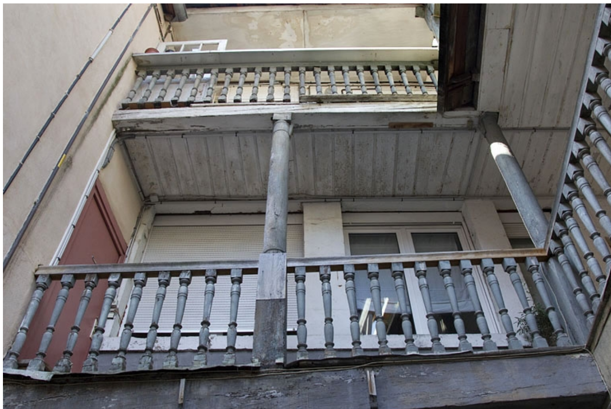
Escalier extérieur : détail des coursières, de face.
