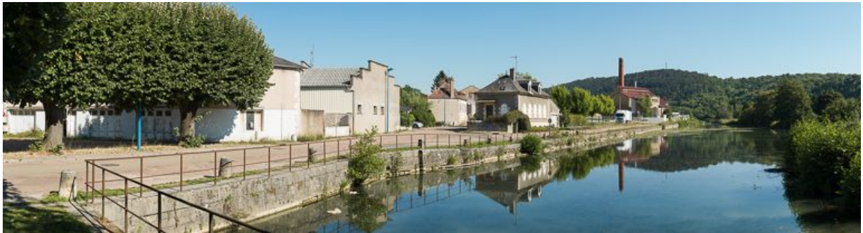
Vue d'ensemble du port de Saint-Roch, d'amont.
