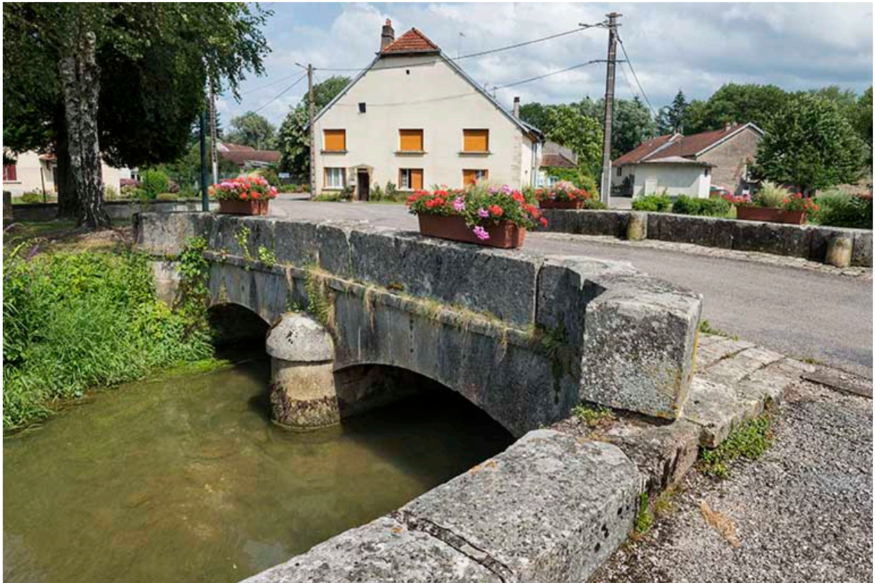
Face nord, vue depuis l'ouest.
