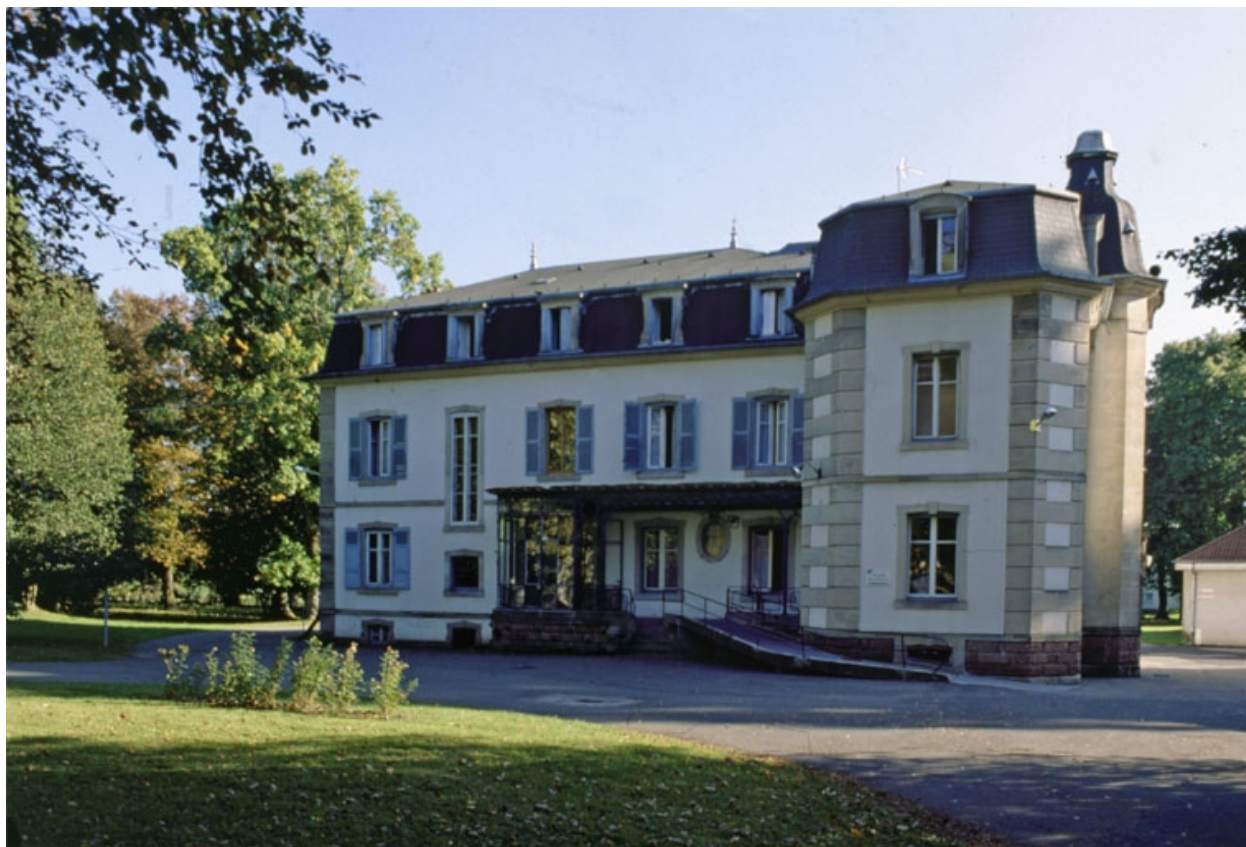
Logement patronal depuis le nord.
