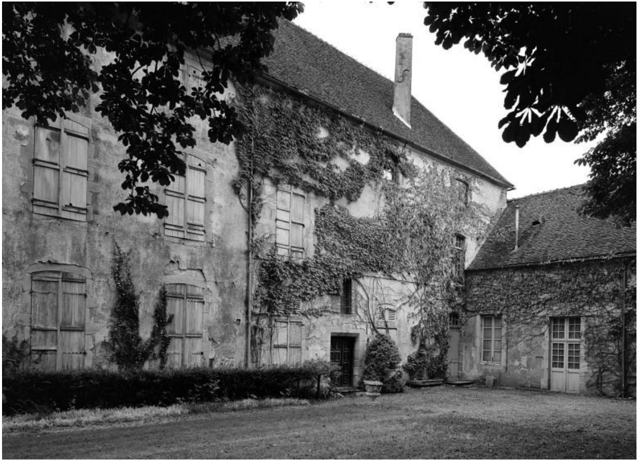
Bâtiment est. Façade prise du nord-est.
