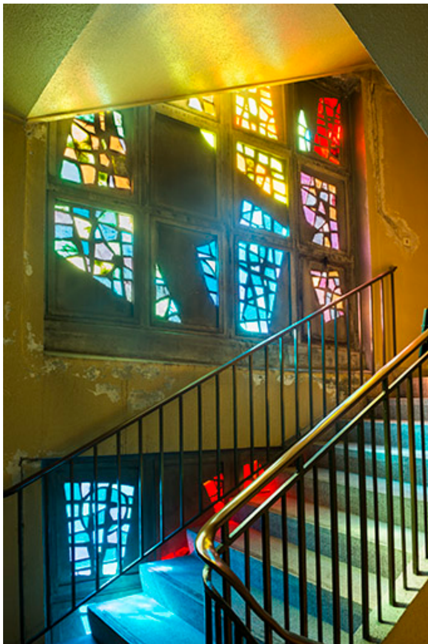
Vue du deuxième niveau.
