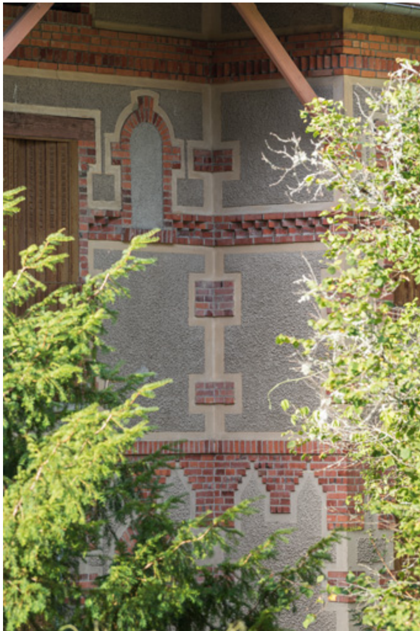
Façade principale, ressaut et décor de brique.
