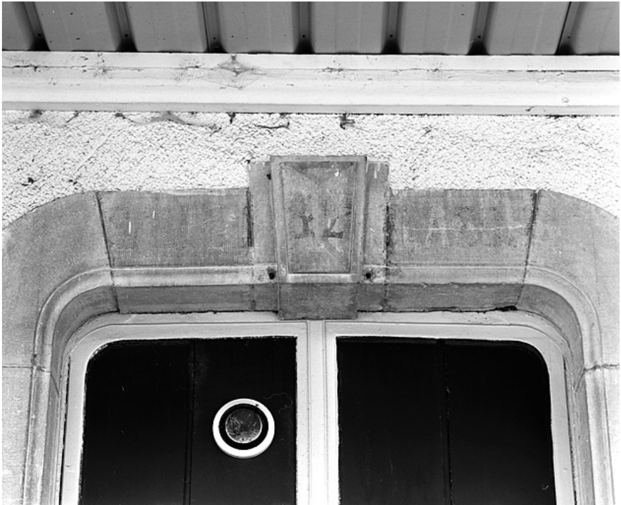
Bâtiment des voyageurs : plate-bande d'une fenêtre.
