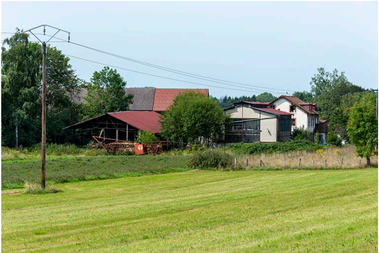
Vue d'ensemble du site, depuis le nord-est.
