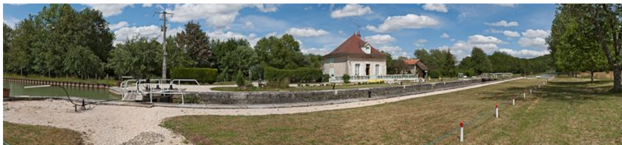
Vue d'ensemble du site d'écluse.
