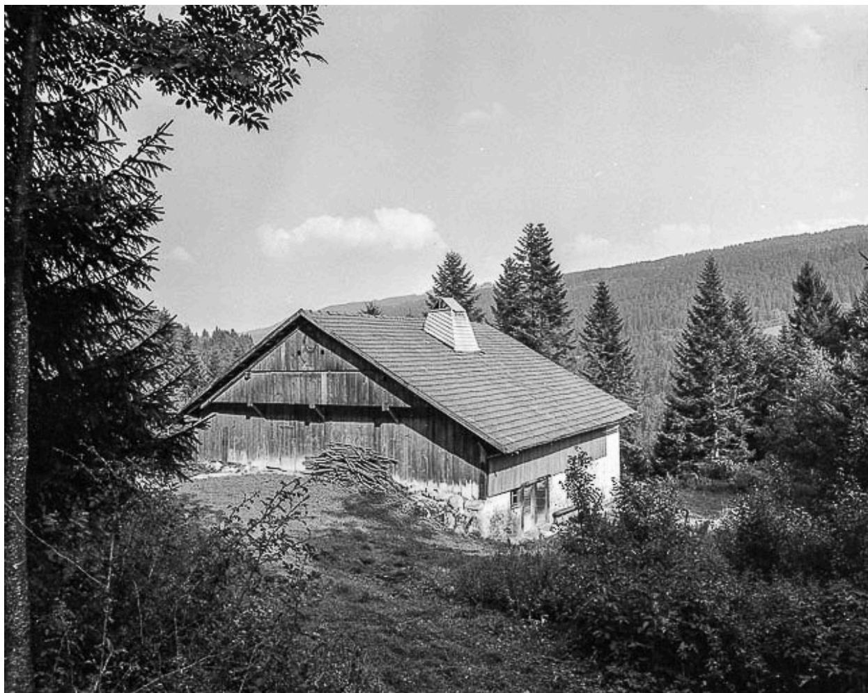
Ferme située au lieu-dit A Gourdavi : façade postérieure et latérale gauche.
