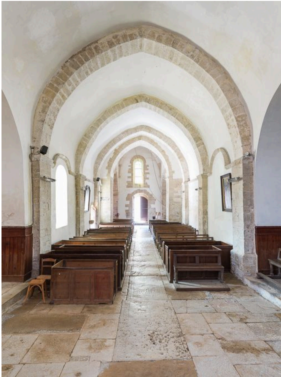
Vue d'ensemble depuis le chœur.
