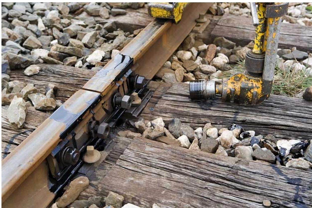
Machine à boulonner et à déboulonner, à visser et à dévisser (tirefonneuse) : tête de serrage (la machine est utilisée pour resserrer des boulons d'éclisses).
