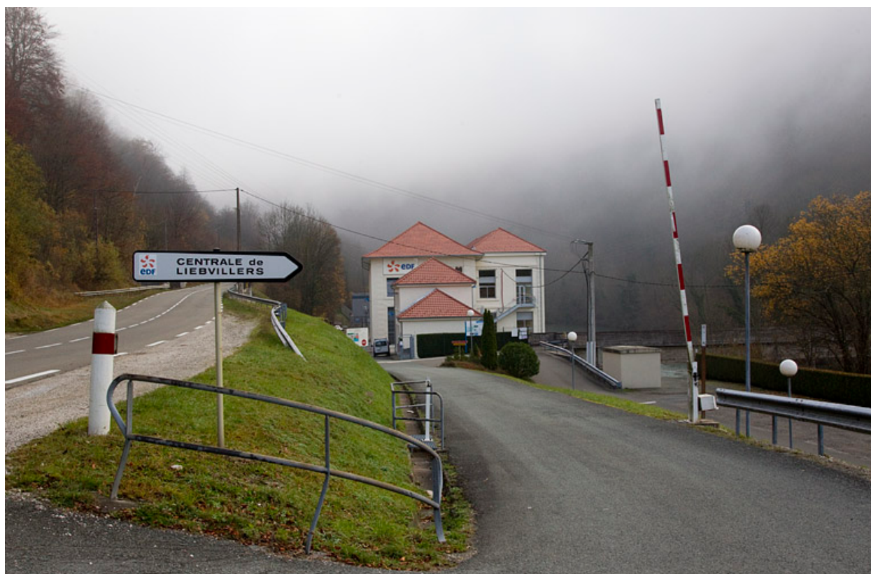
Vue d'ensemble depuis l'ouest (aval rive droite).
