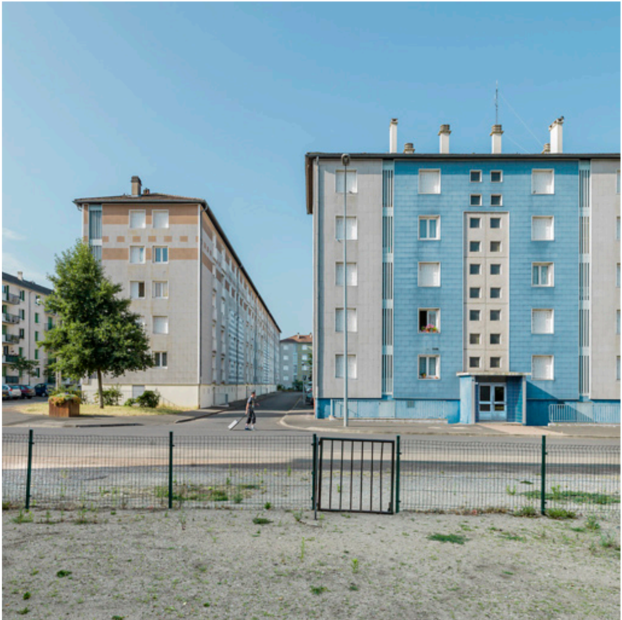
Bâtiment E, façades latérale et postérieure ; bâtiment I façade antérieure.
